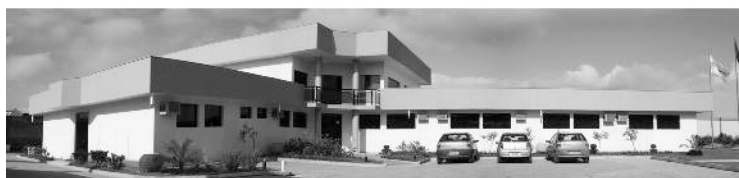
Instalações da Metroval - Macaé - RJ
