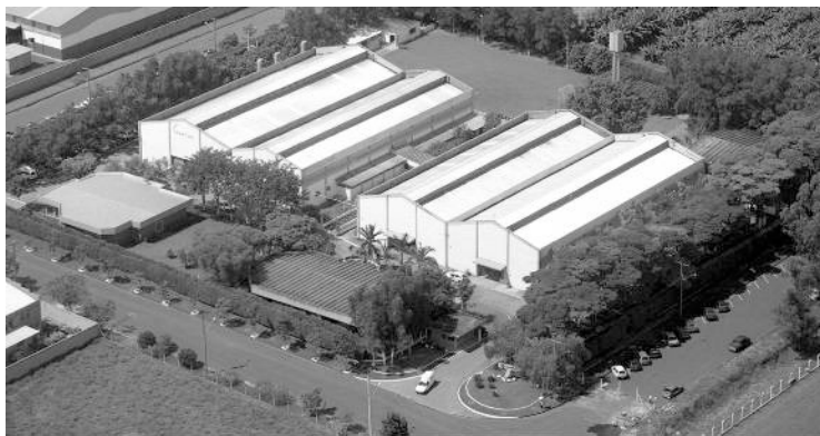
Instalações da Metroval - Nova Odessa - SP
