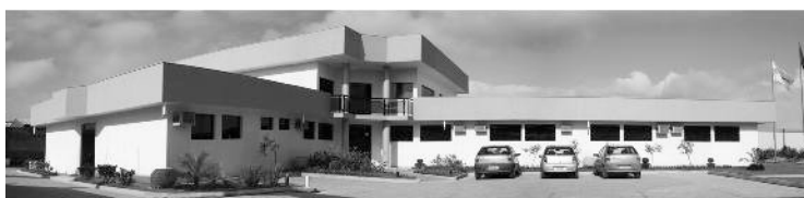
Instalações da Metroval - Macaé - RJ
