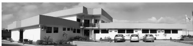
Instalações da Metroval - Macaé - RJ
