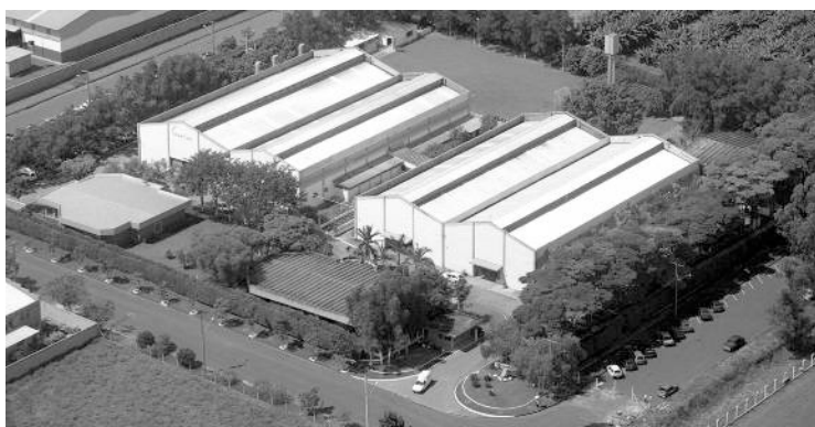
Instalações da Metroval - Nova Odessa - SP
