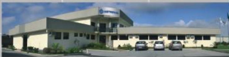
Instalações da Metroval - Macaé - RJ
