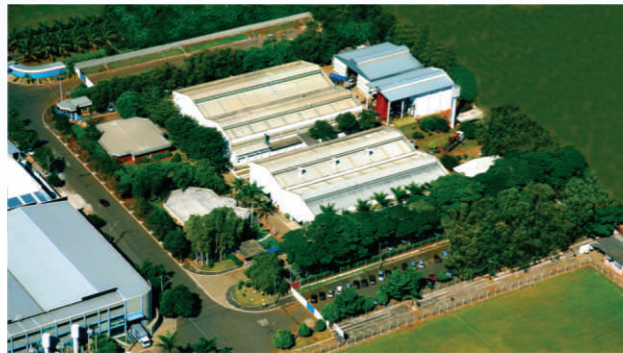
Instalações da Metroval - Nova Odessa - SP
