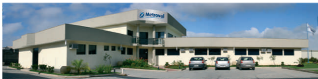
Instalações da Metroval - Macaé - RJ
