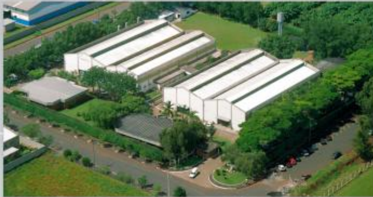
Instalações da Metroval - Nova Odessa - SP
